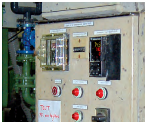
■ Alte elektromechanische und neue speicherprogrammierbare Reaktorsteuerung.
